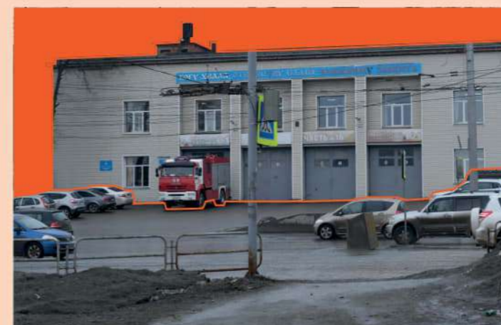
Нерешенный узел УДС у пожарной станции
